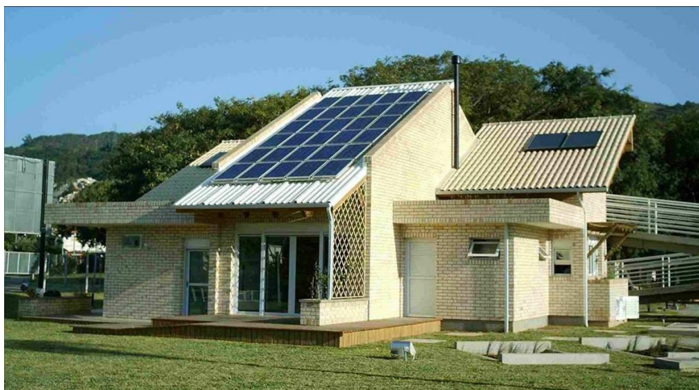
Figura 6. Vista externa da Casa Eficiente, observando-se o painel fotovoltaico (cobertura central) e coletores solares orientados a Norte (LABEEE, 2006)
