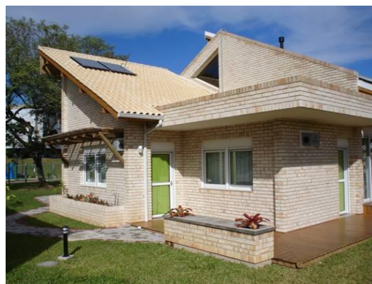
Figura 5. Vista das fachadas leste e norte (LABEEE, 2006)
