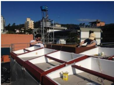
Figura 13: Isolamento externo das coberturas e vedação das telhas
