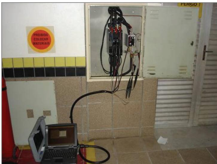
**Figura 29 – Equipamento de medição da curva de carga instalado no circuito principal de alimentação do prédio.**
