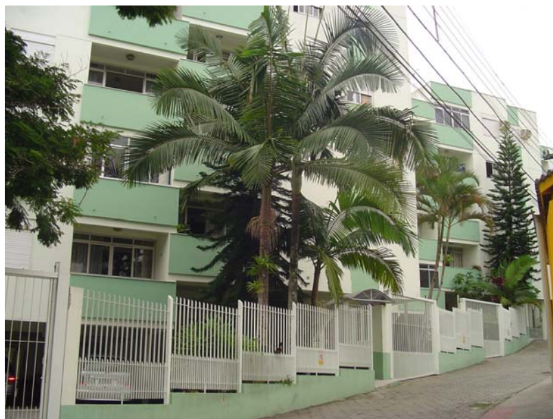
Figura 3.1 – Fachada principal do Condomínio – vista do blocos A e B
