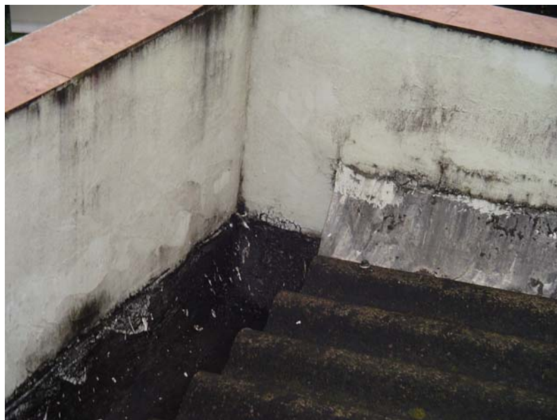
Figura 3.3 – Vista do beiral do telhado, mostrando a calha de concreto impermeabilizada e o rufo
