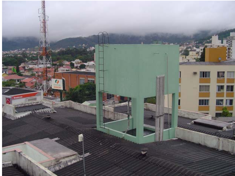
Figura 3.2 – Vista geral do telhado do bloco A
