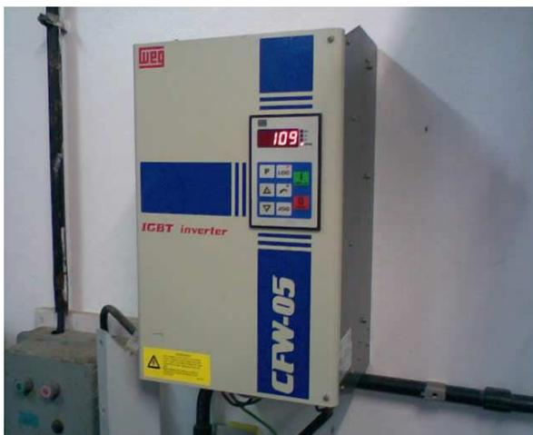
Figura 3.5 – Comando elétrico para variar a velocidade do ar no túnel de vento.
