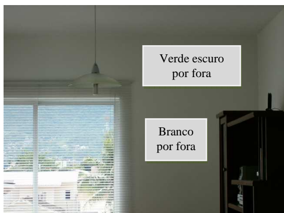
Figura 80. Diferentes tintas na fachada exterior 2
