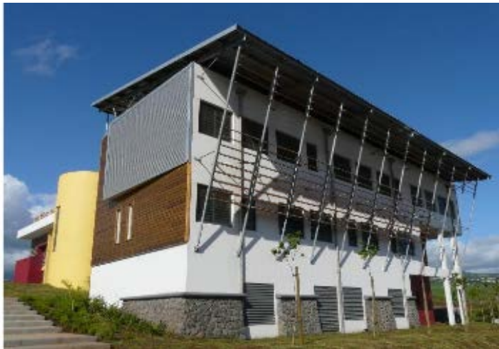
Figura 23: Edifício Enerpos na ilha de Reunião.
