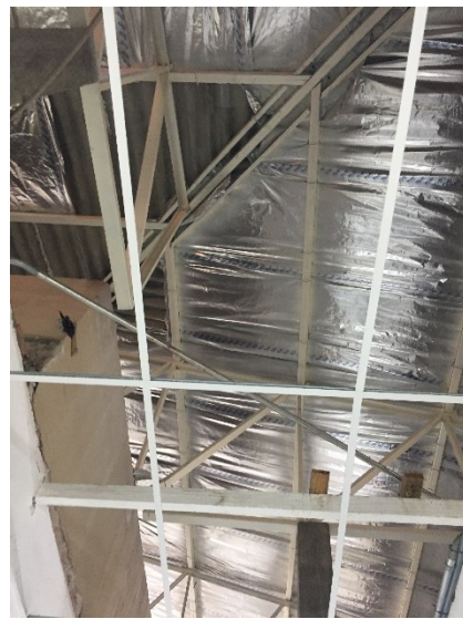
(d) Detail: radiant barrier above the roofing
