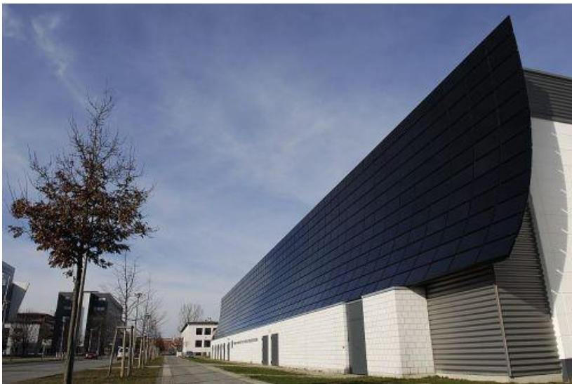
Figura 6 – Instituto Ferdinand-Braun (fonte: http://www.solarfassade.info ).
