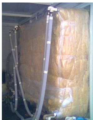
Figura 3-31. Isolamento das tubulações e das cavidades
