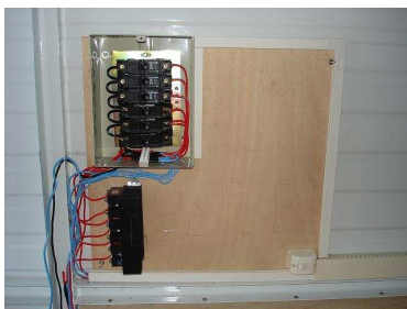
Figura 3-28. Quadro de distribuição elétrica
