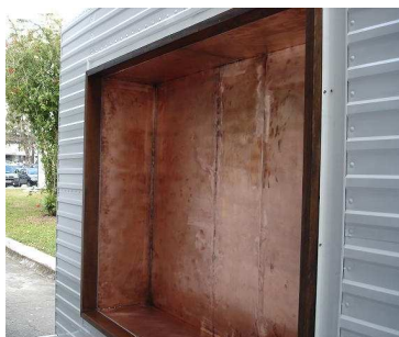
Figura 3-24. Vista externa da cavidade principal já instalada no trailer
