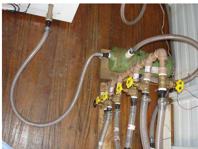
Figura 3-30. Ligação da bomba e barrilete com registros de controle de fluxo da CP
