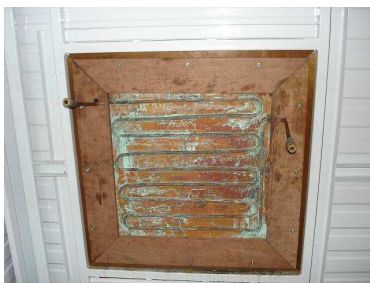
Figura 3-26. Detalhe interno da cavidade secundária já instalada no trailer
