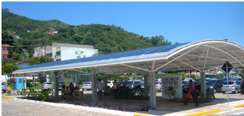
Figura 18. Planta-piloto de 11,97 kWp, localizada no pátio de estacionamento do edifício-sede da Eletrosul, em Florianópolis – SC.
