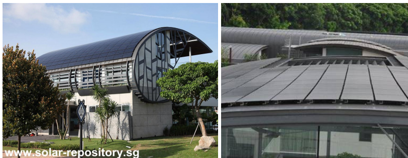
Figura 30. Sistema A: Gerador solar fotovoltaico instalado seguindo a cobertura curva da residência em Cingapura. Detalhe para a distância de aproximadamente 10 cm entre os módulos e a cobertura da edificação.
