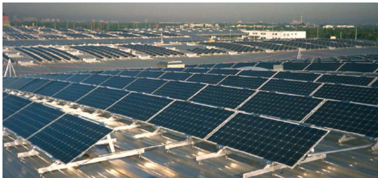
Figura 7. Munich Trade Fair Centre: instalação de 1 MW na cobertura (CUNOW e GIESLER, 2001).
