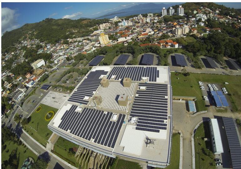
Figura 8. Megawatt Solar: 1,1 MWp instalado sobre a cobertura do Edifício Sede da Eletrosul e de estacionamentos, instalado na cidade de Florianópolis, SC (UFSC, 2014).
