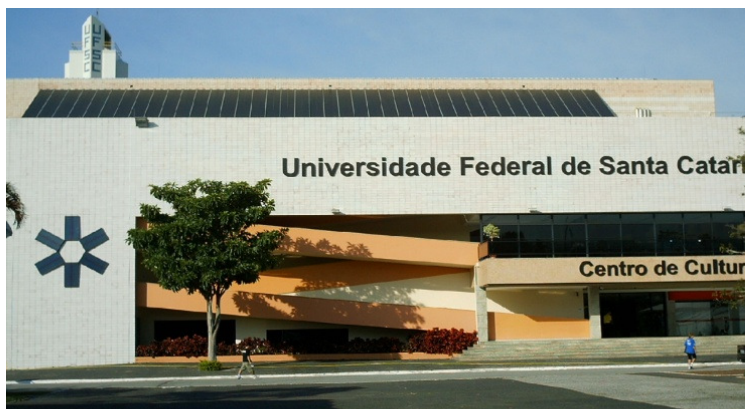
Figura 41 – Sistema fotovoltaico plano inclinado a 27^\circ\text{N} , com 10,24 kWp, integrado ao Centro de Cultura e Eventos da UFSC.
