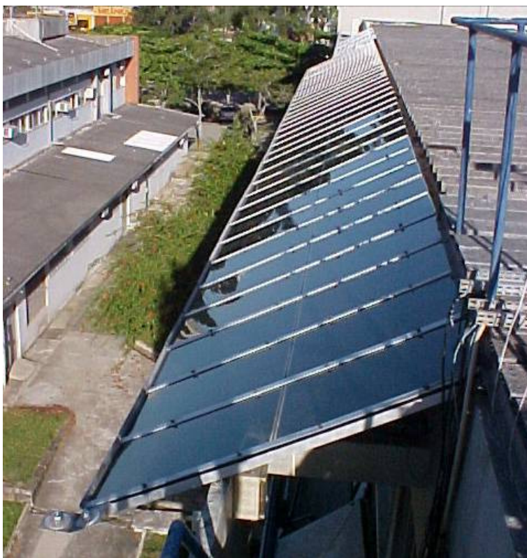
Figura 15. Primeiro sistema fotovoltaico conectado à rede e integrado a uma edificação no Brasil: Sistema de 2 kWp - Florianópolis-SC.
