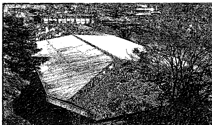
Figura 1.4 - BLOCO E34 - Face Sudeste à esquerda e Noroeste à direita no período de inverno. Sistema Construtivo com Bloco Cerâmico 4 furos e Telhamento em Alumínio
