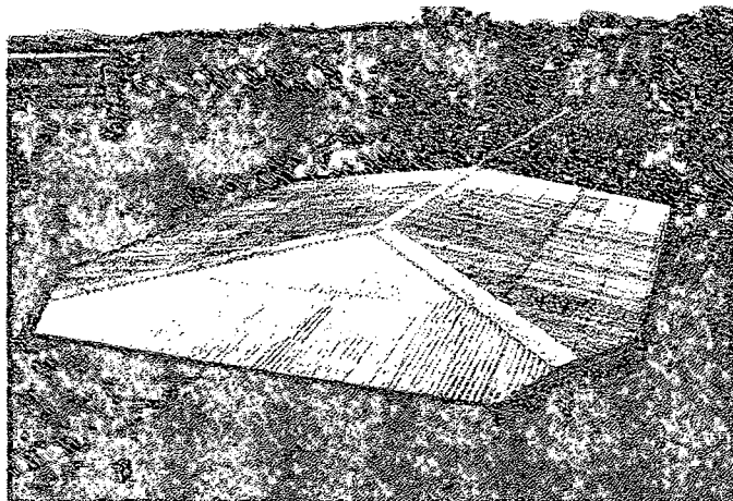
Figura 1.3 - BLOCO E46 - Face Oeste à esquerda e Leste à direita no período de inverno. Sistema Construtivo com Bloco Cerâmico 4 furos e Telhamento em Alumínio
