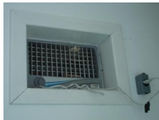
Figura 2.14 – Insuflador de ar posicionado no quarto de solteiro.
