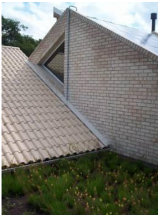
Figura 2.10 – Telhas cerâmicas (quarto de casal) e teto-jardim (quarto de solteiro).
