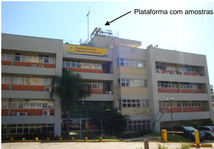
Figura 6 – Plataforma posicionada na cobertura de prédio da UFSC.
