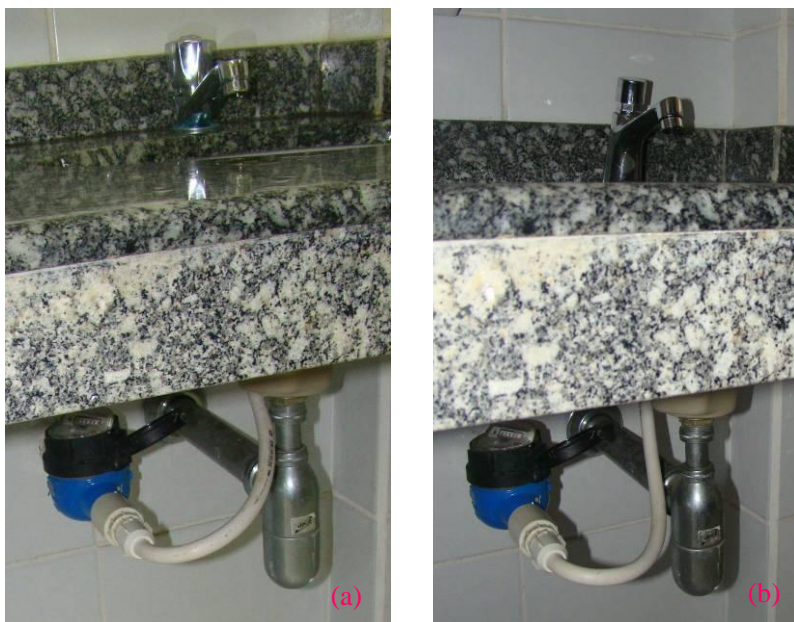
Figura 8 – Hidrômetro instalado em uma torneira convencional (a) e economizadora de água (b).
