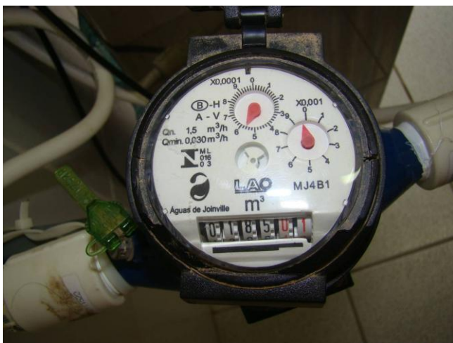
Figura 12 – Exemplo de hidrômetro utilizado no diagnóstico de consumo de água do bloco K do CCT-UDESC.
