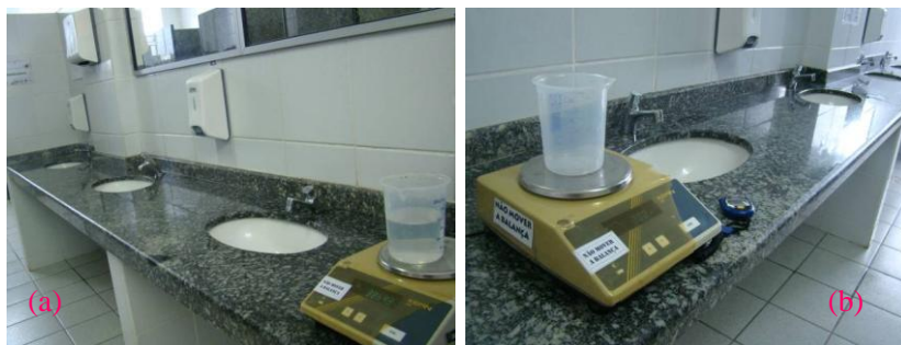
Figura 13 – Medição de vazão no banheiro masculino do segundo andar (a) e no banheiro feminino do primeiro andar (b) e os instrumentos utilizados.
