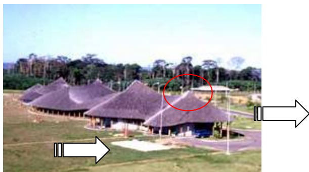
Figura 4-18- Proteção ambiental – Centro de Balbina.
