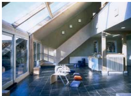
Figura 3-40- Ganho solar passivo na fachada sul.
