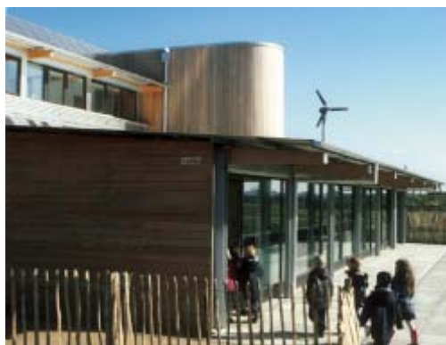
Figura 3-59- Madeira de florestas plantadas. Beirais dimensionados, proteção no verão. (www.penoyre-prasad.net)
