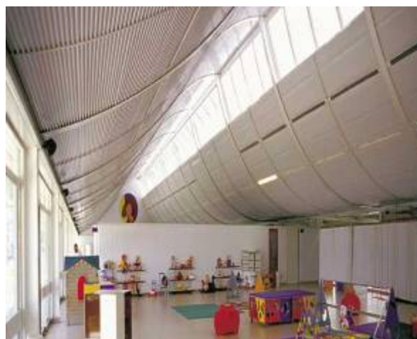
Figura 4-21 - Vista interna da sala de fisioterapia infantil. Iluminação e ventilação natural com Sheds.
