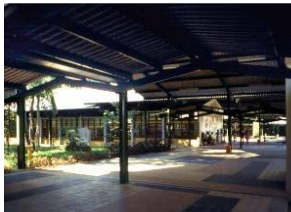
Figura 3-15- Coberturas e beirais amplos.
