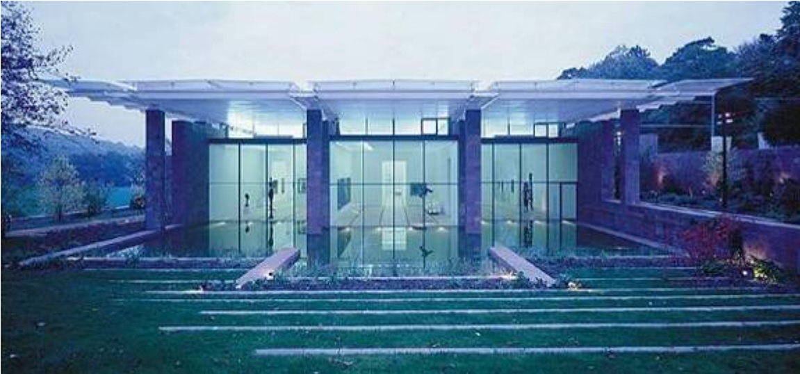
Figura 2-8- Elevação sul do Museu da Fundação Beyeler de Renzo Piano- Telhado como elemento arquitetônico de controle (Fonte: (BUCHANAN, 2005))
