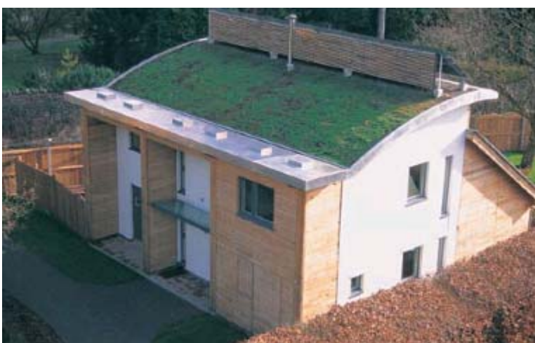
Figura 3-38- Vista da Fachada Norte e do telhado verde. (Fonte: www.jesticowhiles.co.uk )
