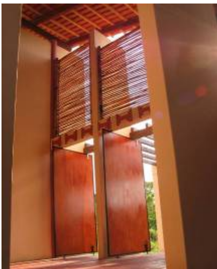
Figura 3-29- Pemeabilidade do edifício. Uso de paredes móveis.
