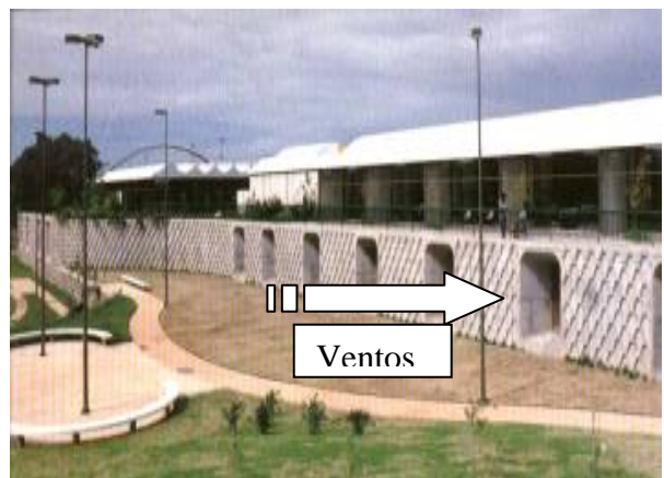
Figura 3-3- Tomada de ar – aberturas das galerias. Salvador Hospital.
