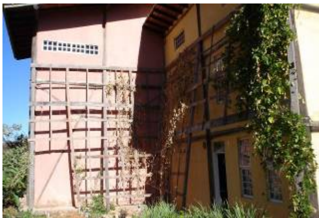
Figura 3-25- Treliça para proteção da fachada Noroeste durante o verão.
