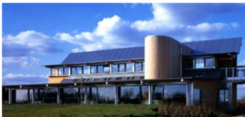
Figura 3-57- Telhado desenhado para adaptar placas fotovoltaicas. Orientação do edifício para proporcionar o aquecimento solar passivo. (www.penoyre-prasad.net)
