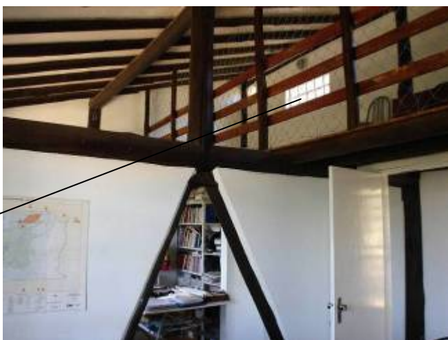
Figura 3-23- Pé-direito elevado. Ventilação cruzada. Estrutura em madeira como parte do aráter plástico.
