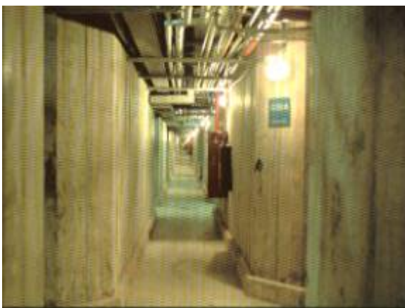
Figura 3-2- Galerias técnicas. Hospital de Salvador
