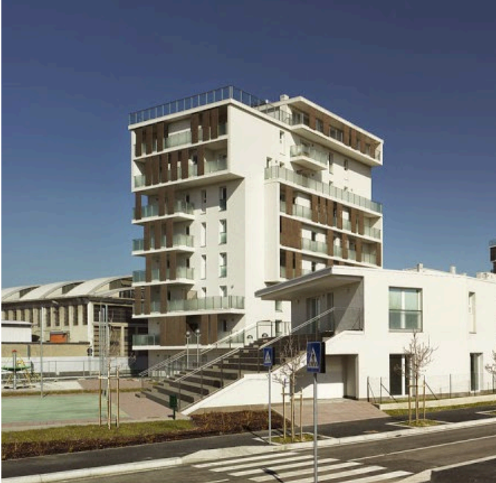
Figura 19– Edificação utilizada como estudo de caso na cidade de Milão.
