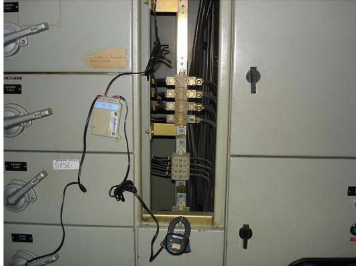
**Figura 10 – Medição de Corrente Elétrica – 31/mai a 3/jun**
