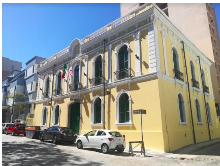
Figura 1 - Fachada do edifício em estudo
