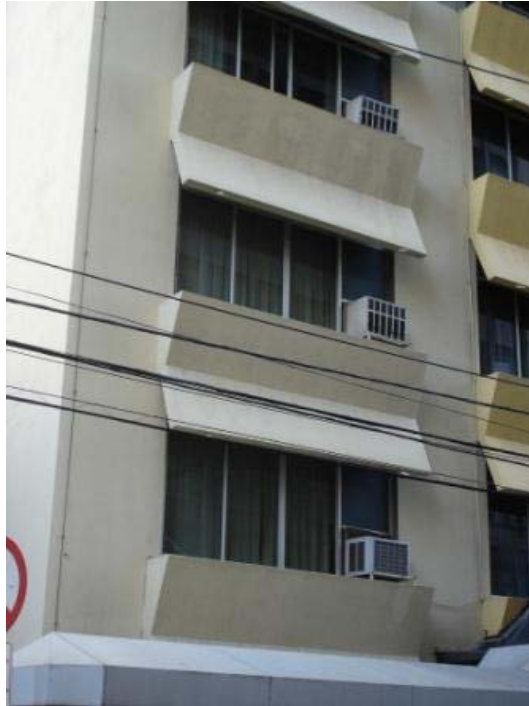
Figura 4. Proteções solares na janela.
