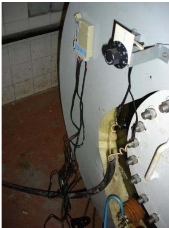
Figura 7. Medição da caldeira elétrica.
