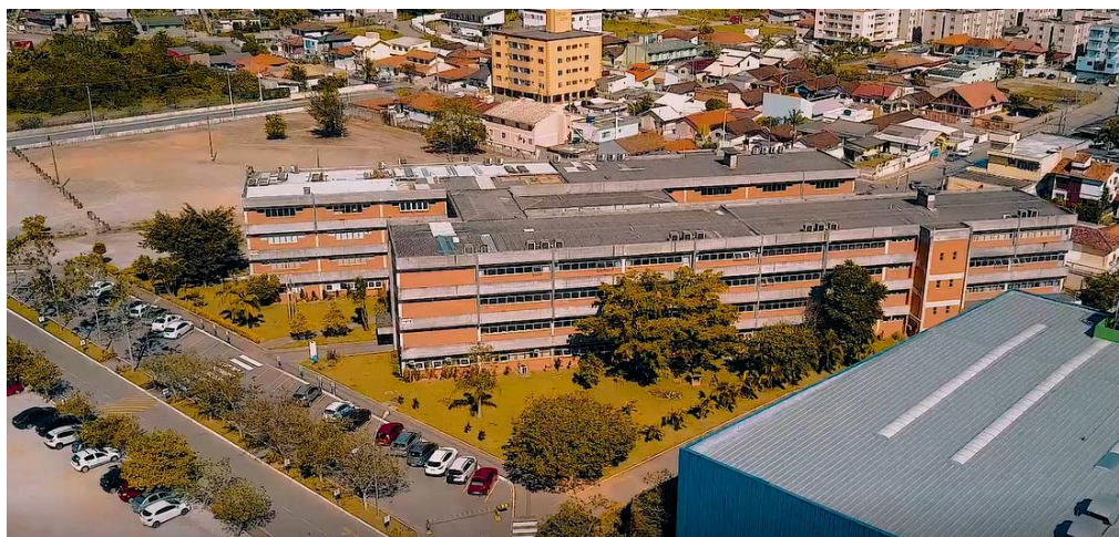
Figura 7: Fachada leste do Bloco 2 da edificação, com Bloco 1 aos fundos.
