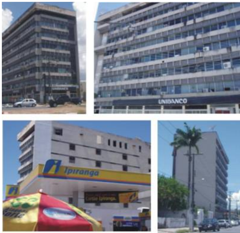
Figura 1.8. Fotos da Fachada do Edifício Empresarial Ruy Palmeira
