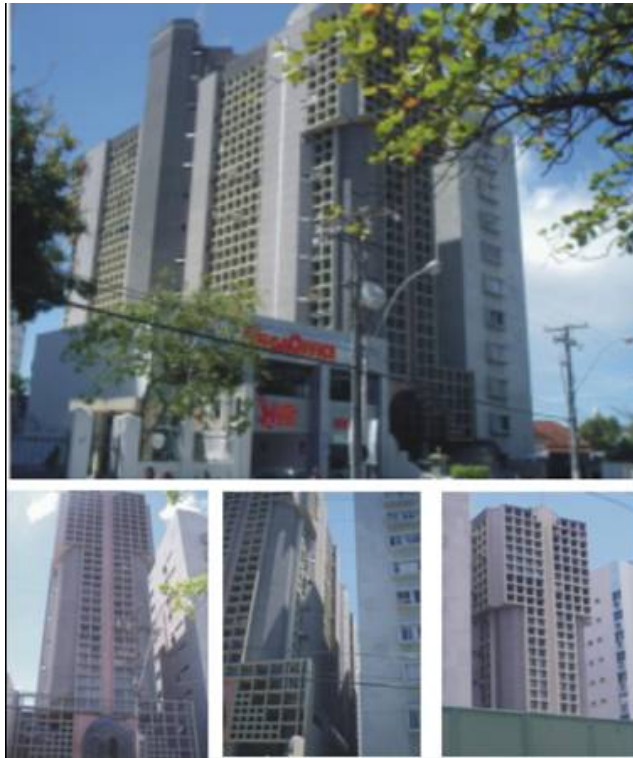
Figura 1.9. Fotos da Fachada do Edifício Work Center
