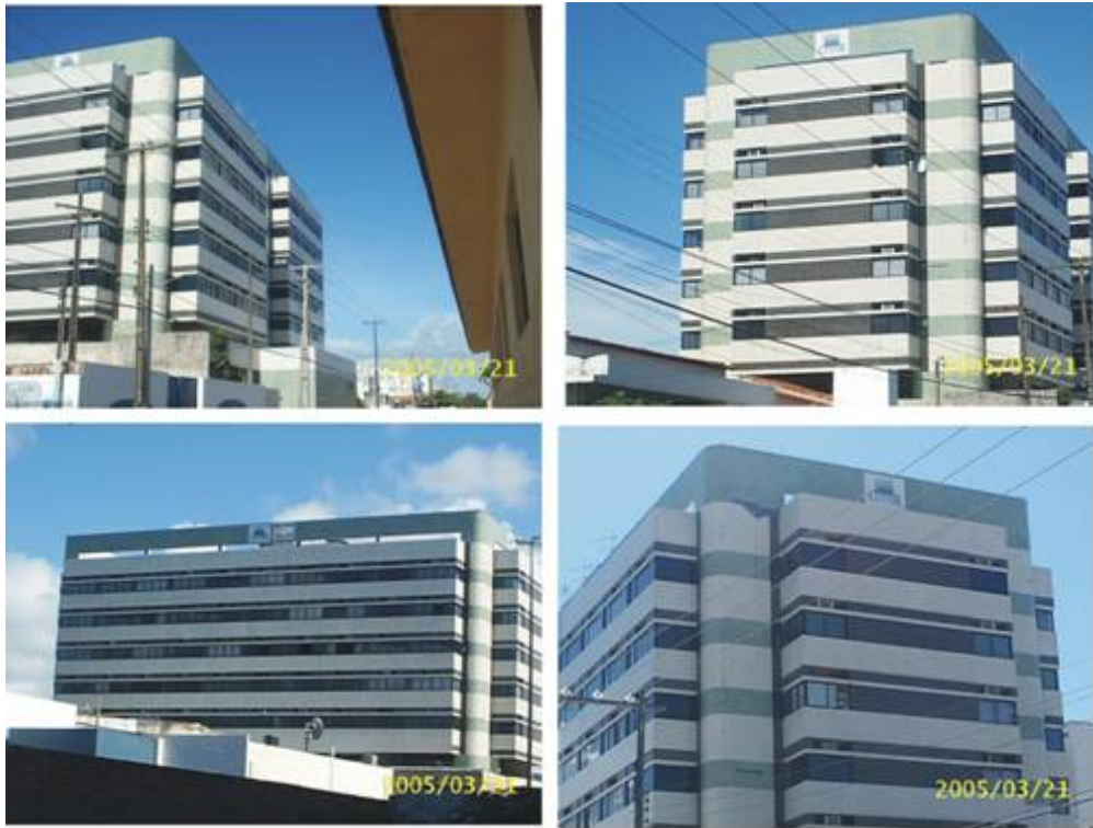
Figura 1.5. Fotos da Fachada do Comercial Trade Center.
