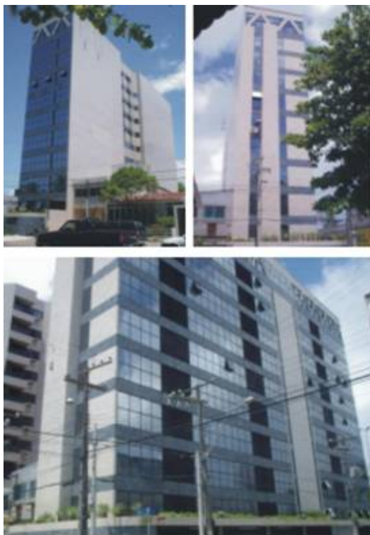
Figura 1.11. Fotos da Fachada do Edifício Breda Centers
