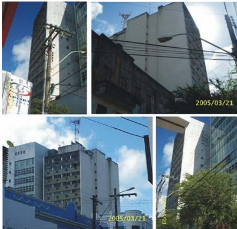
Figura 1.1. Fotos da Fachada do Edifício Walmap.
