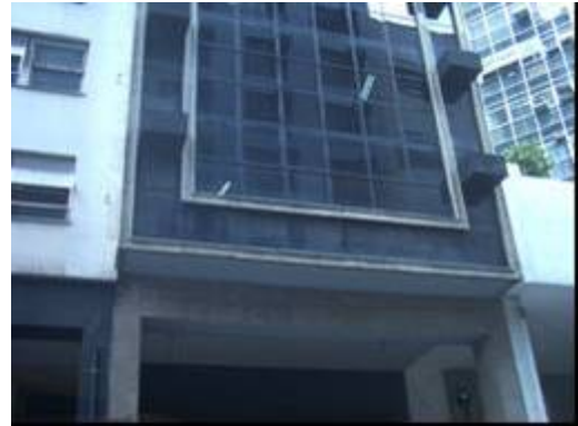
Figura 2.2. Detalhe da Fachada – Ed. Office Center
