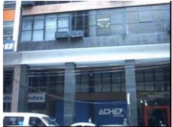
Figura 2.35. Vista do Térreo - Ed. Centro Emp. Tirante
