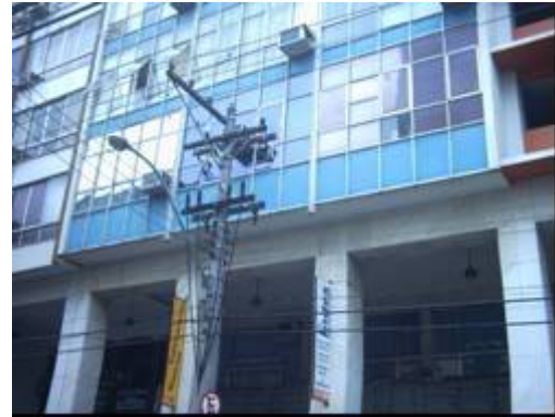
Figura 2.10. Vista do Térreo - Ed. Ruy Barbosa
