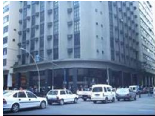
Figura 2.28. Vista do Térreo - Ed. Working Center
