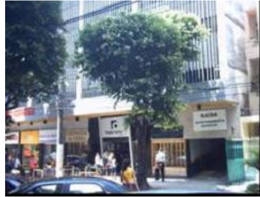
Figura 2.49. Vista do Térreo - Ed. Trade Center
