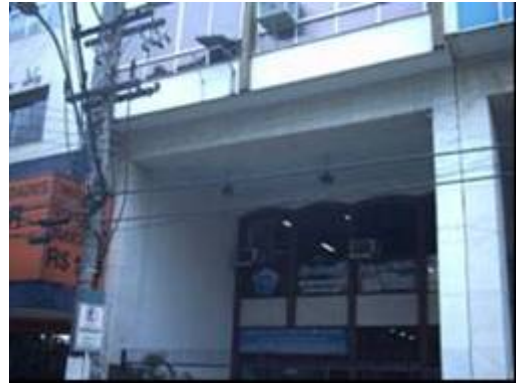
Figura 2.12. Vista do Térreo - Ed. Ruy Barbosa
