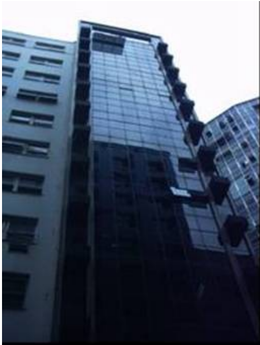
Figura 2.1. Ed. Office Center
