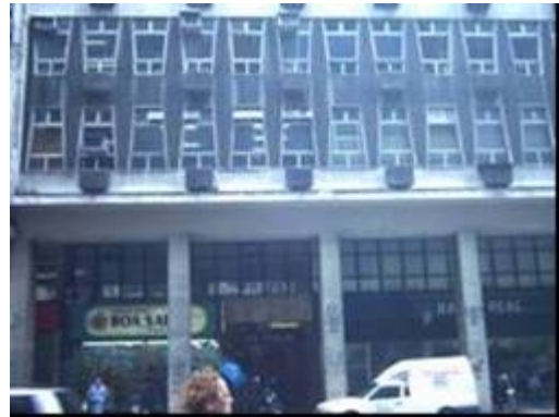
Figura 2.16. Vista do Térreo - Ed. Fórum
