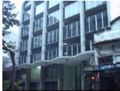
Figura 2.47. Vista do Térreo - Ed. Center Sul
