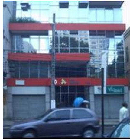
Figura 2.43. Vista do Térreo - Ed. Top Center
