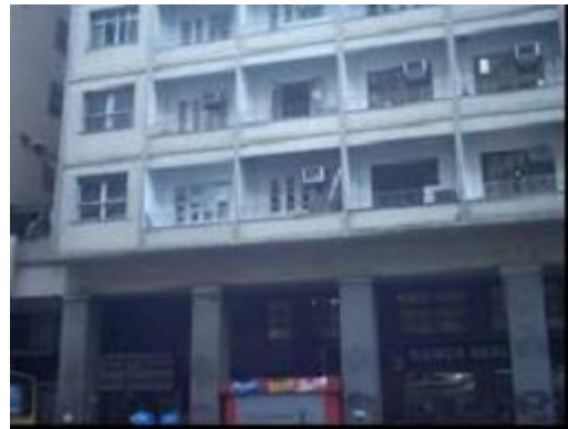
Figura 2.55. Vista do Térreo - Ed. Metrópole
