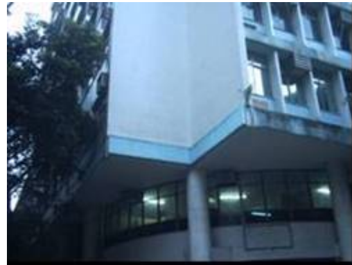
Figura 2.41. Vista do Térreo - Ed. Monte Carlo
