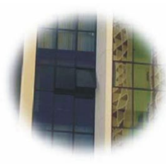
Figura 2.25. Centro Executivo Barra Sul
