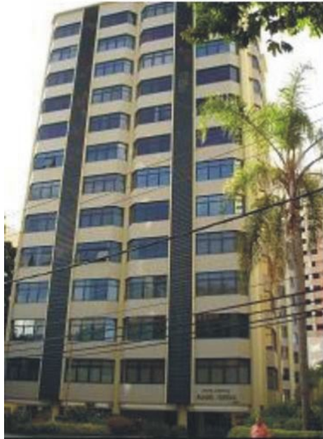
Figura 1.28. Foto da Fachada: Edifício Panel Towers.
