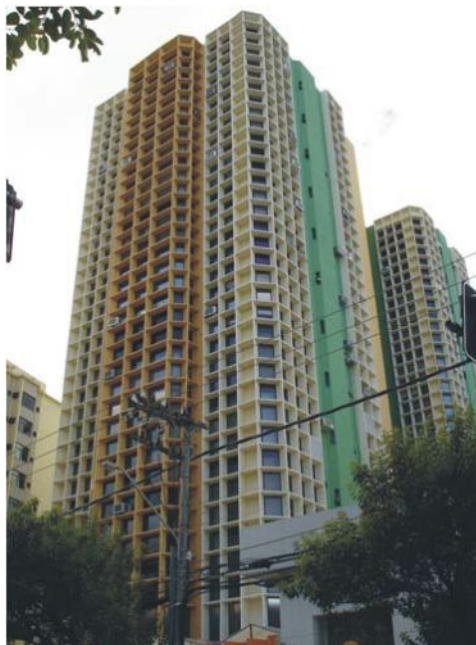
Figura 1.15. Foto da Fachada: Centro Executivo Maxim's
