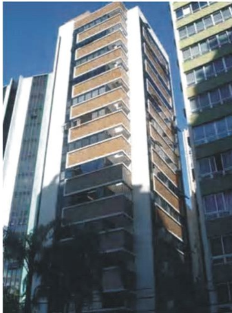
Figura 1.17. Foto da Fachada: Centro Executivo Via Venneto
