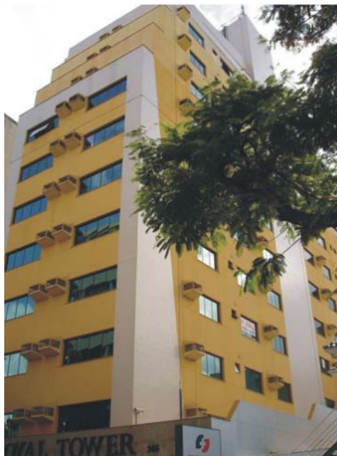
Figura 1.30. Foto da Fachada: Edifício Royal Tower.
