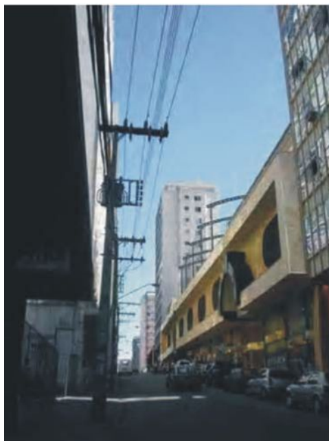
Figura 1.10. Foto da Fachada: Centro Empresarial Fênix
