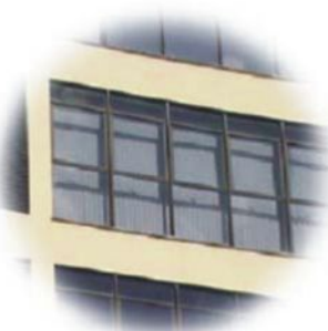
Figura 2.18. Centro Comercial Granemann
