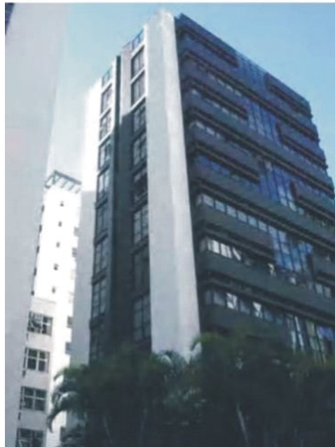
Figura 1.22. Foto da Fachada: Edifício Manhattan.
