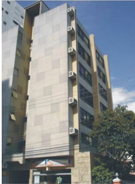
Figura 1.1. Foto da Fachada: Edifício Alexander Fleming
