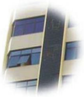
Figura 2.26. Edifício Planel Towers
