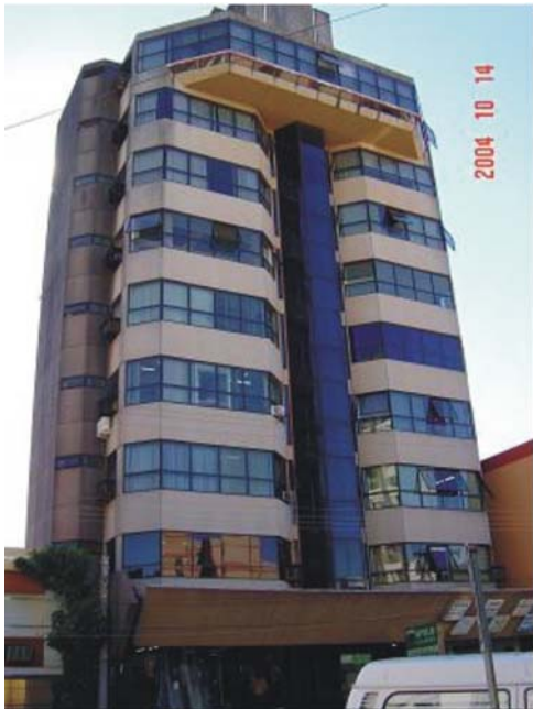
Figura 2.8. Foto da Fachada: Edifício Panorama
