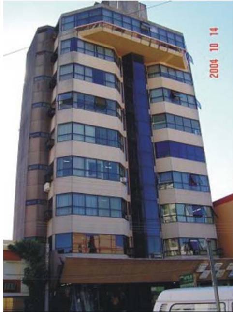
Figura 3.2. Levantamento fotográfico das fachadas do prédio escolhido da tipologia E.
