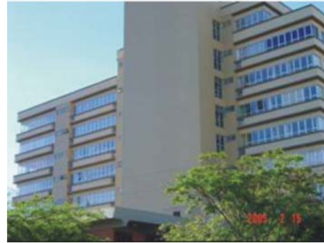
Figura 2.2. Detalhe da Fachada: Edifício Comercial Hass Center
