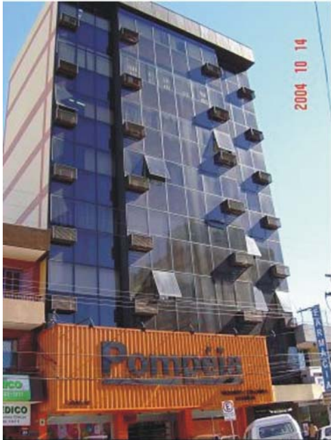
Figura 2.10. Foto da Fachada: Edifício Jamile
