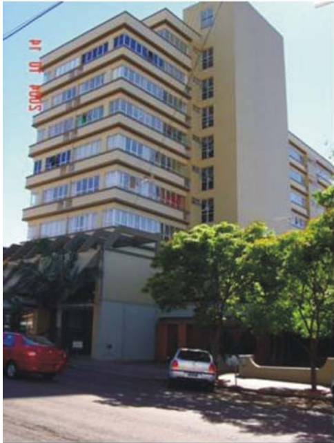
Figura 2.1. Foto da Fachada: Edifício Comercial Hass Center
