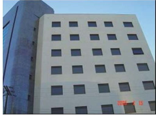
Figura 2.15. Detalhe da Fachada: Edifício Fórum.
