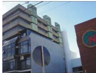
Figura 2.7. Detalhe da Fachada: Edifício Shopping JB
