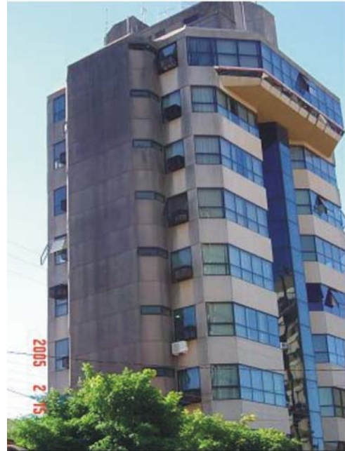
Figura 2.9. Vista Lateral: Edifício Panorama
