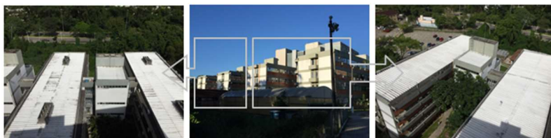
Figura 4.6 - Fachada das quatro edificações do local 3 - CCB MIP (centro), cobertura das duas últimas edificações (esquerda) e das duas primeiras (direita).
