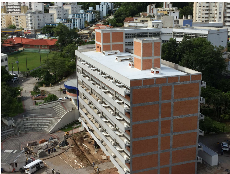
Figura 4.8 - Vista aérea do local 5 - novo prédio do EQA.
