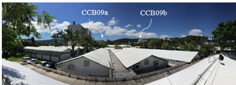
Figura 4.25 - Panorama do local 1 com planta de cobertura e características dos espaços.
