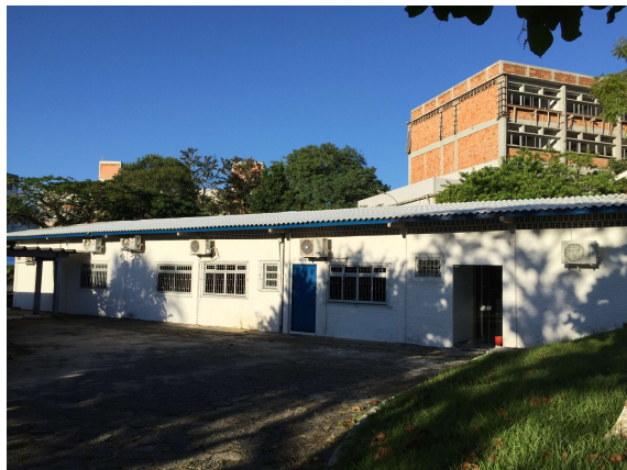
Figura 4.5 - Fachada frontal do local 2 - DMPI.
