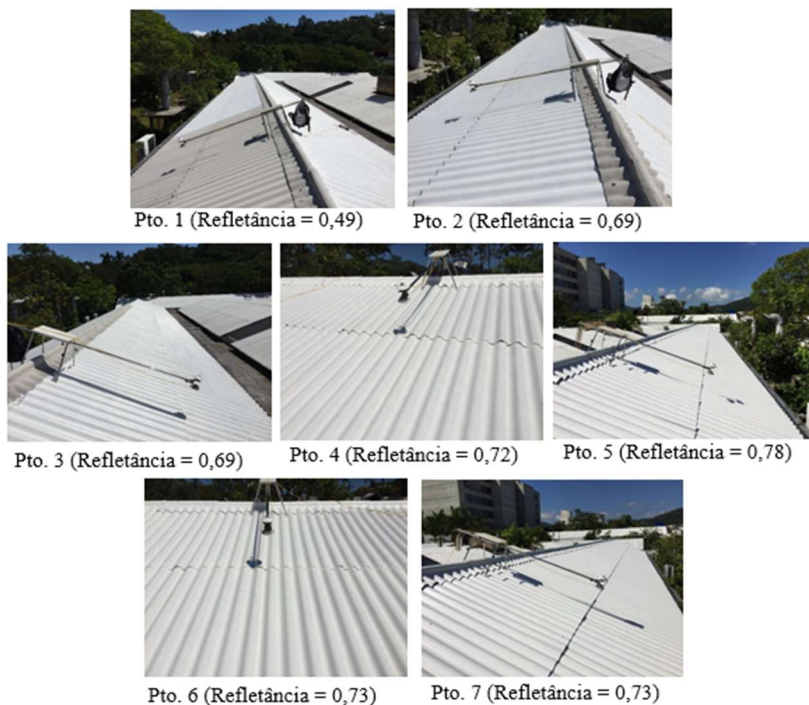
Figura 4.18 - Planta de cobertura com localização e imagem dos pontos escolhidos – CCB09c.
