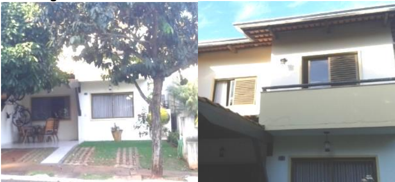
Figura 6 - Fachada frontal da residência monitorada.
