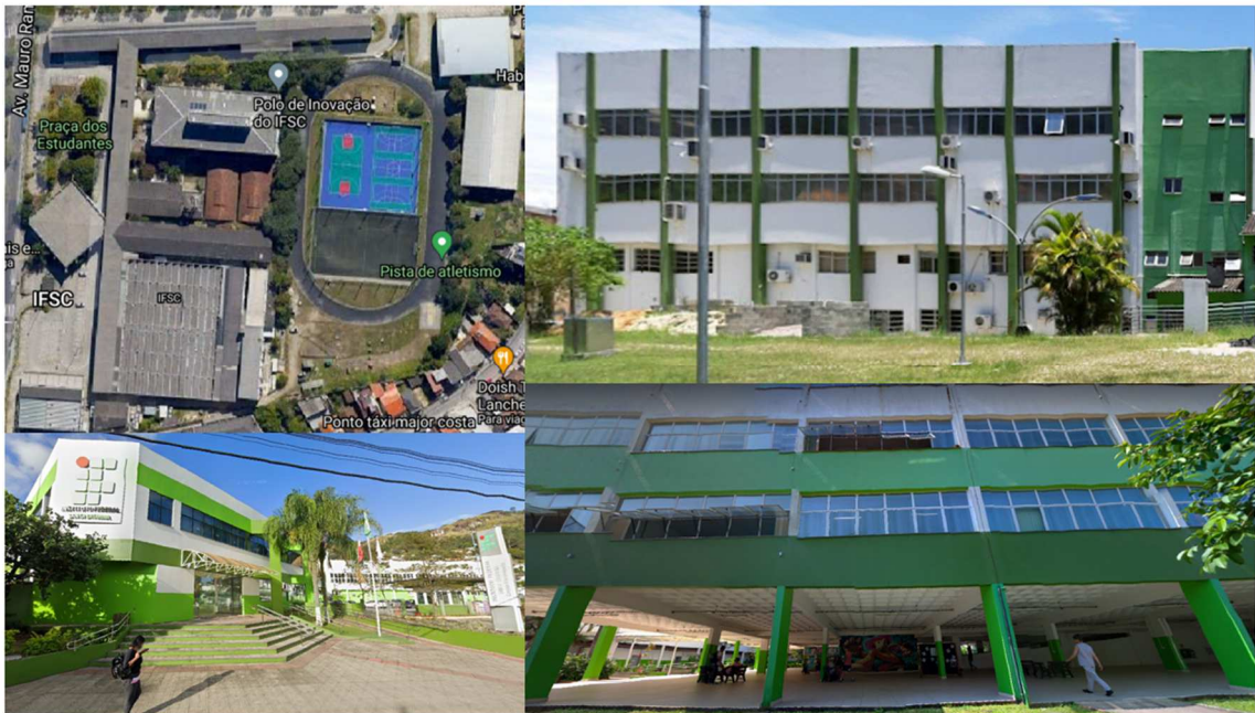
Figura 6 – Edificações IFSC campus Florianópolis.
