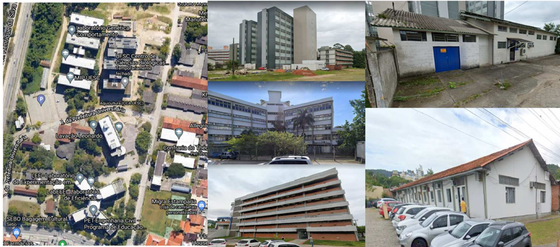
Figura 5 – Edificações do CMD02 UFSC
