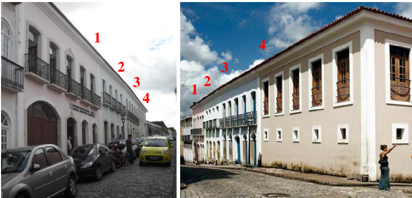
Figura 16 – Conjunto de sobrados (1 a 4) que compõem a edificação, visto da Rua da Estrela a partir de dois ângulos opostos
