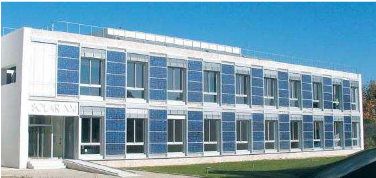
Figura 3.4: Fachada Sul do edifício Solar XXI, dotada de painéis fotovoltaicos integrados [78].
