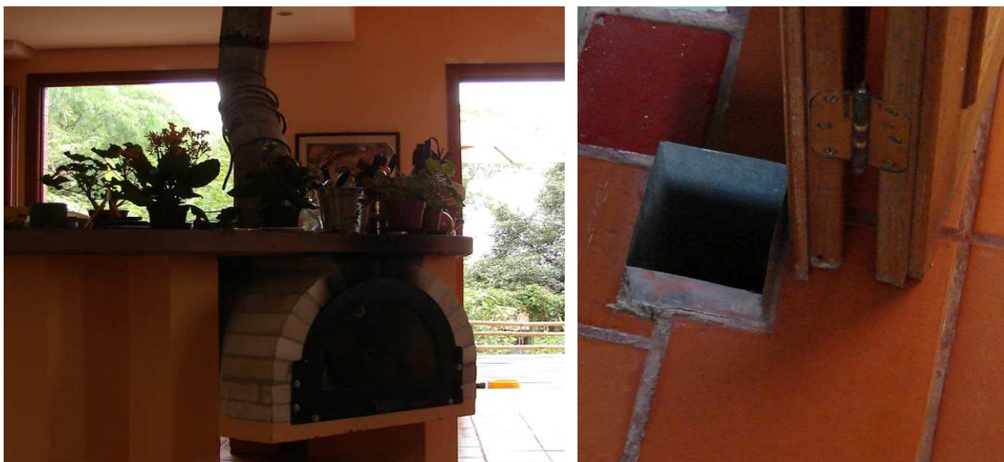
Figura 3.2: Pormenores das edificações: à esquerda: lareira a lenha ; à direita: saída de ar aquecido [78].
