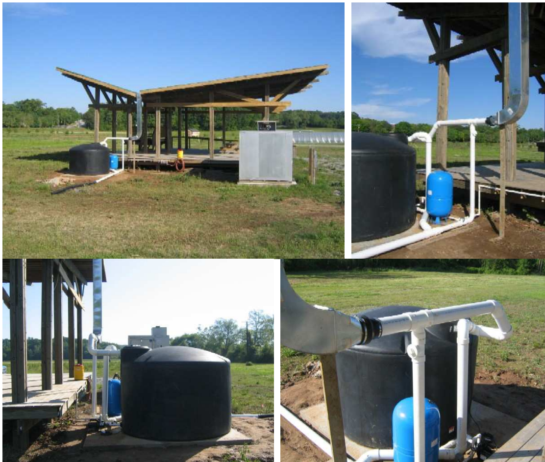
Figura 2.58: Exemplo de um sistema de aproveitamento de água da chuva (pormenores de ligações e do depósito de armazenamento) [56].
