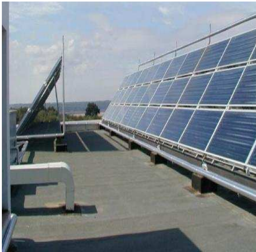
Figura 2.44: Integração de colectores solares em edifícios [44].
