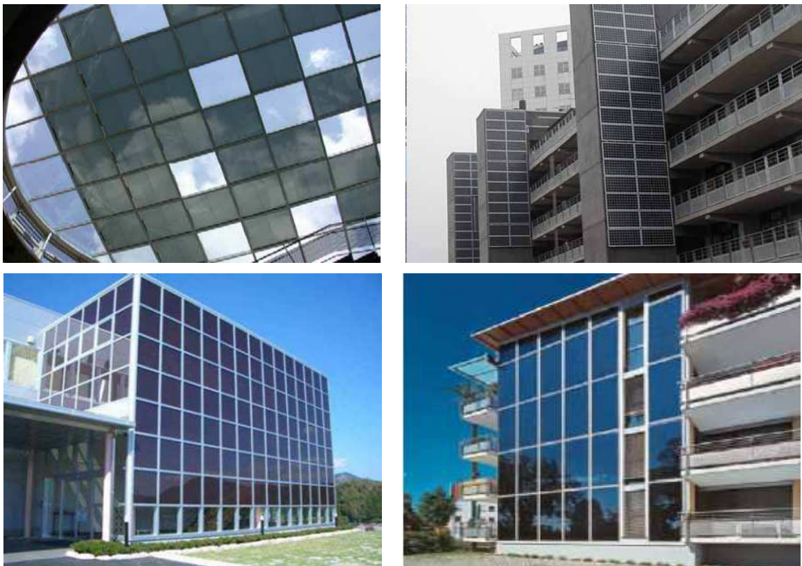
Figura 2.27: Exemplos de BIPV em fachadas e coberturas [29].
