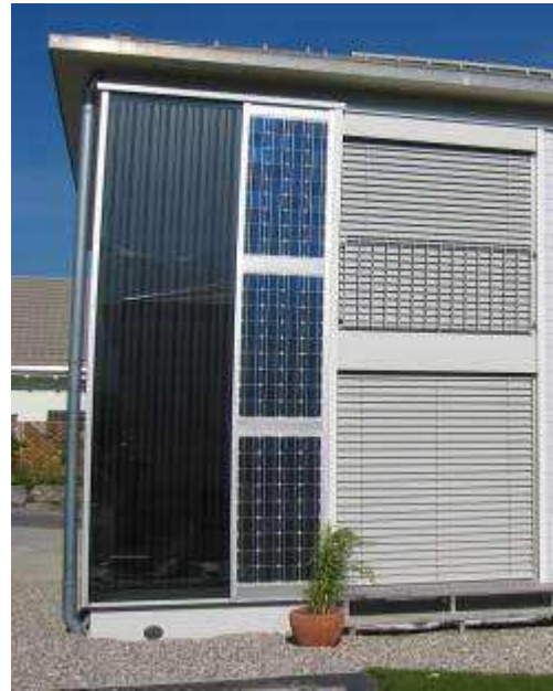
Figura 2.43: Integração de colectores solares em edifícios, [42],[43].
