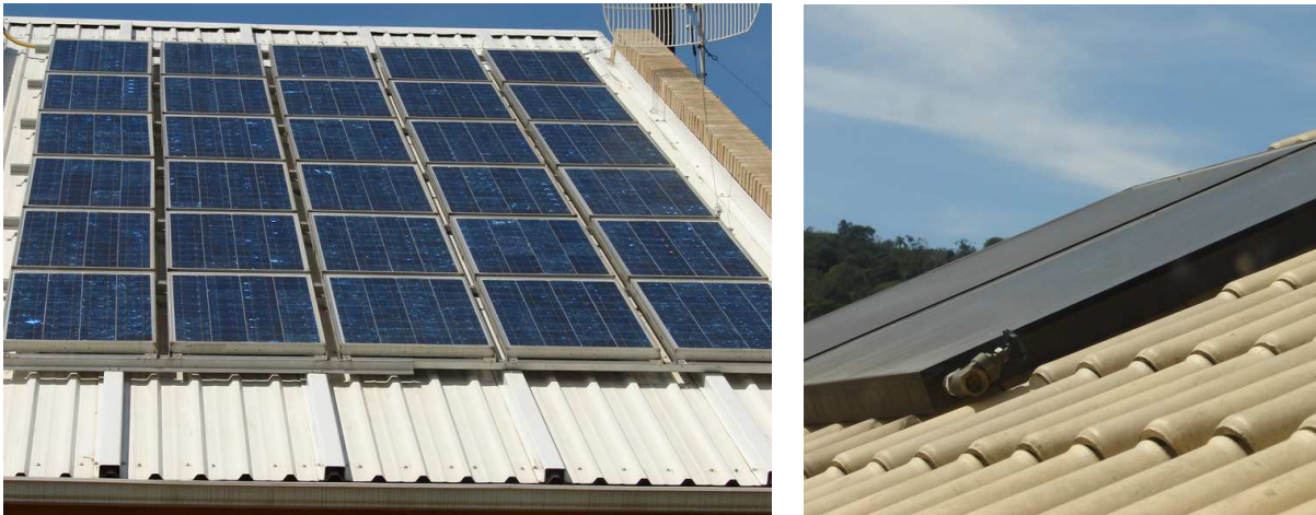
Figura 4.18: Pormenor da instalação do sistema fotovoltaico (esquerda) e do sistema solar térmico (direita) [84].
