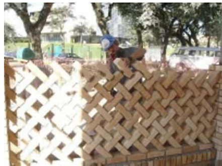
Figura 4.9: Pormenor da execução de uma parede externa de alvenaria vazada. Esta parede situada na fachada Sul, actua como mecanismo de redução da velocidade do vento [81].
