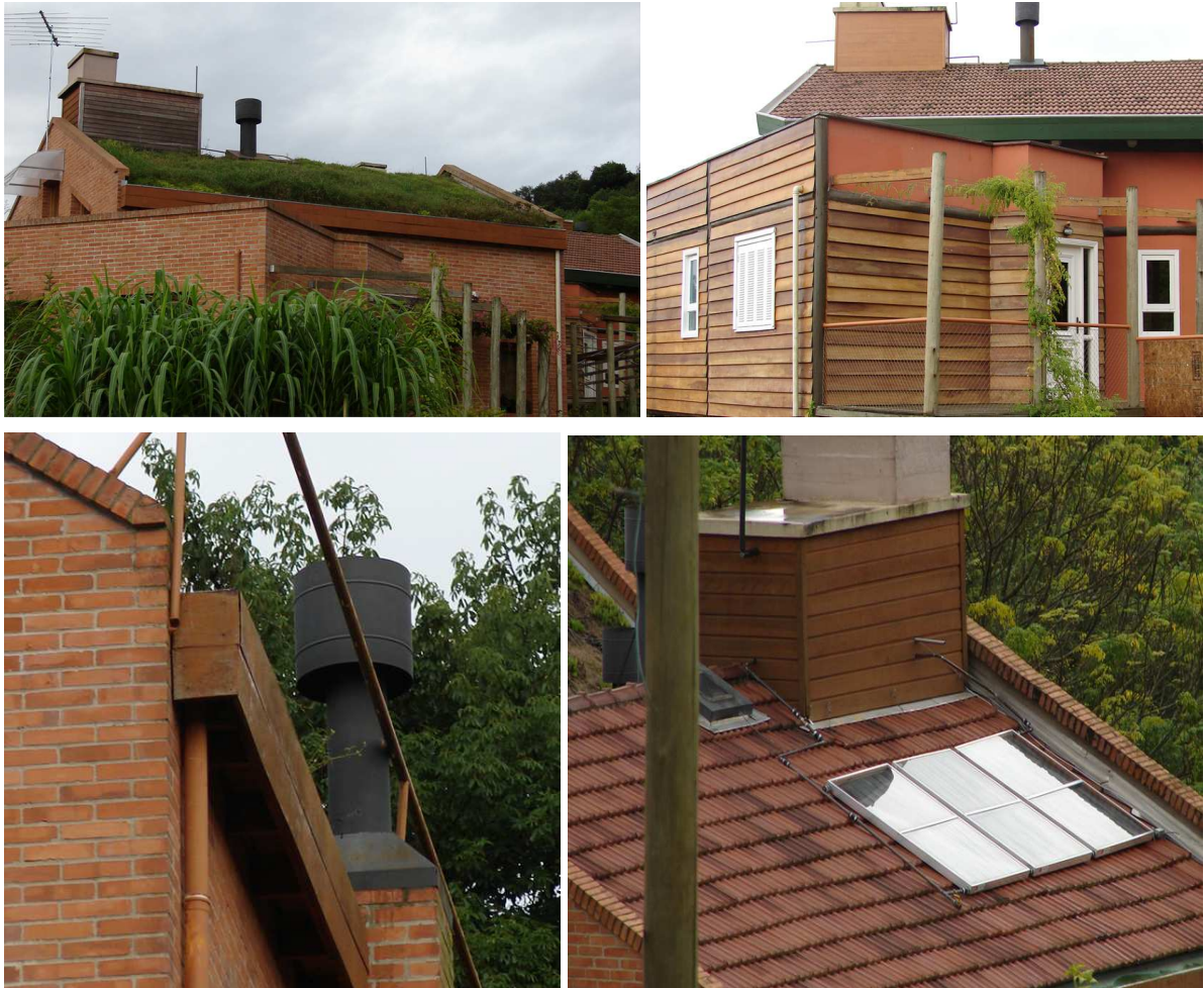
Figura 3.3: Outros aspectos da ecovila: denotar o telhado jardim, os colectores solares, os materiais das edificações e os tanques de aproveitamento de águas pluviais [78].
