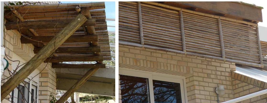
Figura 4.12: Pormenores de protecções solares horizontais e verticais [84].
