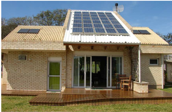
Figura 4.13: Fachada Norte da Casa Eficiente [84].
