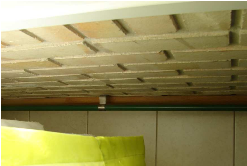
Figura 4.17: Pormenor do tubo de cobre do sistema de aquecimento dos quartos [84].
