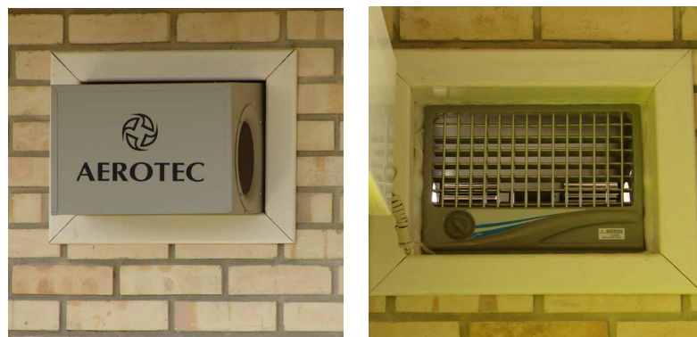
Figura 4.16: Pormenor do equipamento de adução de ar nocturno exterior para arrefecimento dos quartos [84].
