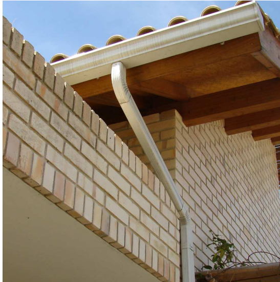
Figura 4.20: Pormenor das calhas de captação [84].
