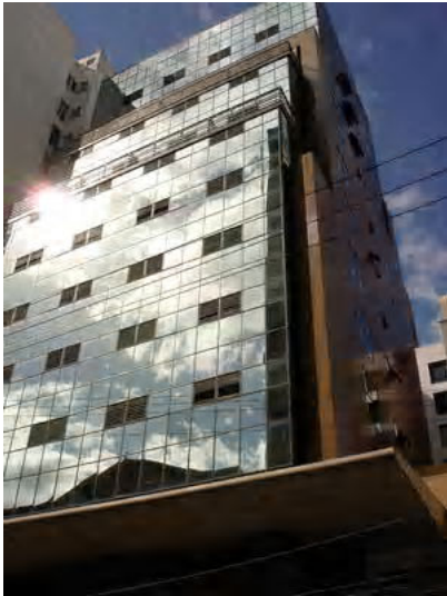
Fig. A4.66- Foto do edifício
