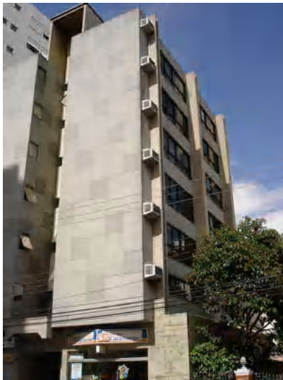
Fig. A4.1- Foto do edifício.
