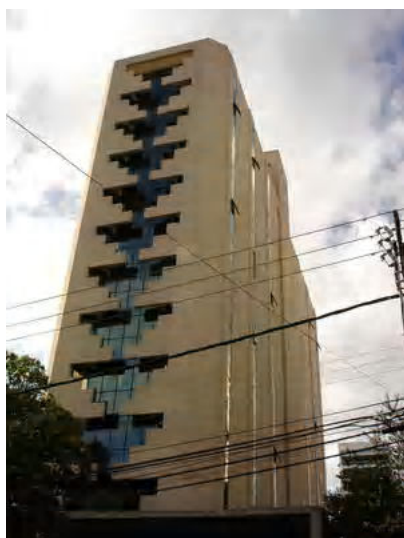
Fig. A4.17- Foto do edifício
