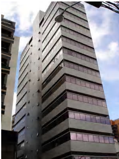
Fig. A4.35- Foto do edifício
