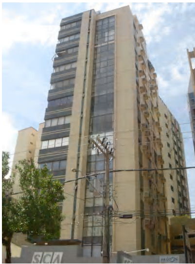
Fig. A4.3- Foto do edifício
