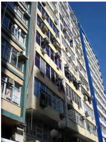
Fig. A4.5- Foto do edifício
