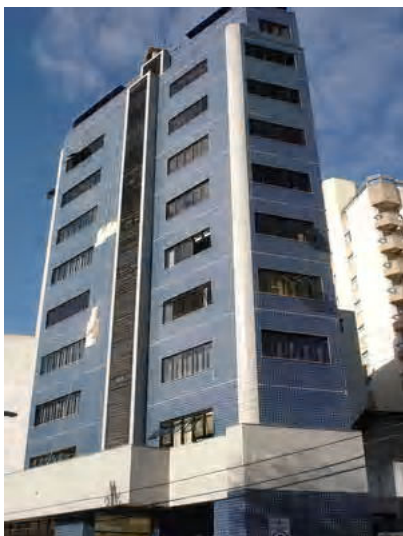
Fig. A4.15- Foto do edifício
