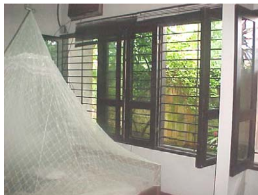
FIGURA 4.24 – As janelas dos quartos ficam constantemente abertas para renovação do ar.
