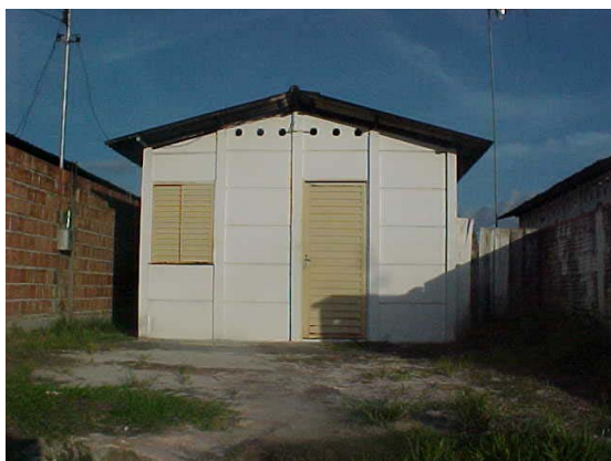
FIGURA 4.25 – Fachada principal – orientação oeste – localização do estar/quarto .
