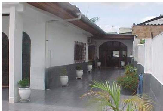
FIGURA 4.15 - Fachada principal – orientação sudeste.
