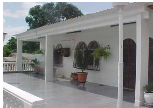
FIGURA 4.16 - Fachada lateral – orientação nordeste.
