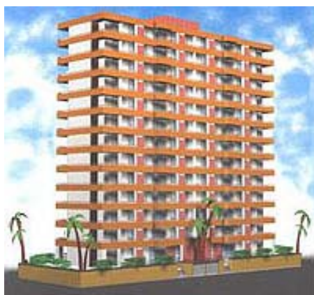
FIGURA 4.18 - Fachada norte do Condomínio Maria da Fé.
