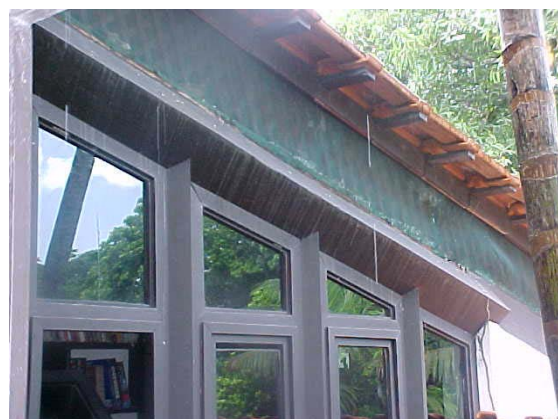
FIGURA 4.22 – Cobertura em telhas cerâmicas, ventilada e protegida dos mosquitos típicos da região.
