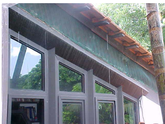
FIGURA 4.27 – Cobertura em telhas cerâmicas, ventilada e protegida dos mosquitos típicos da região.
