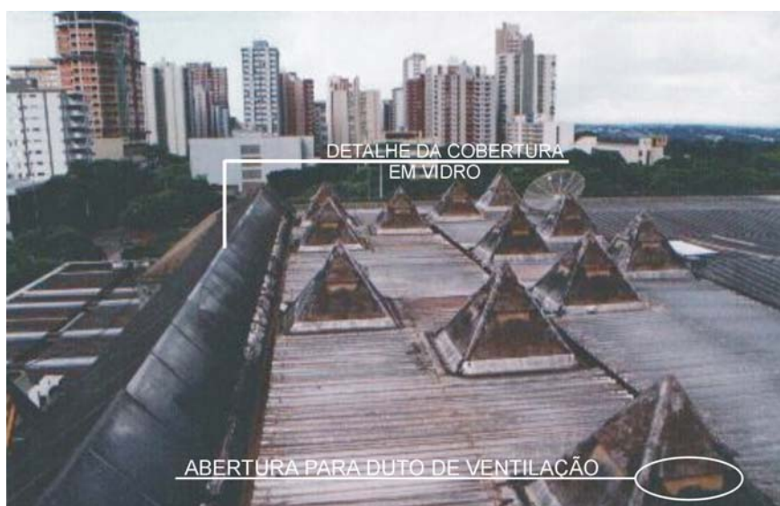
Figura 3.9: Detalhe da cobertura.
