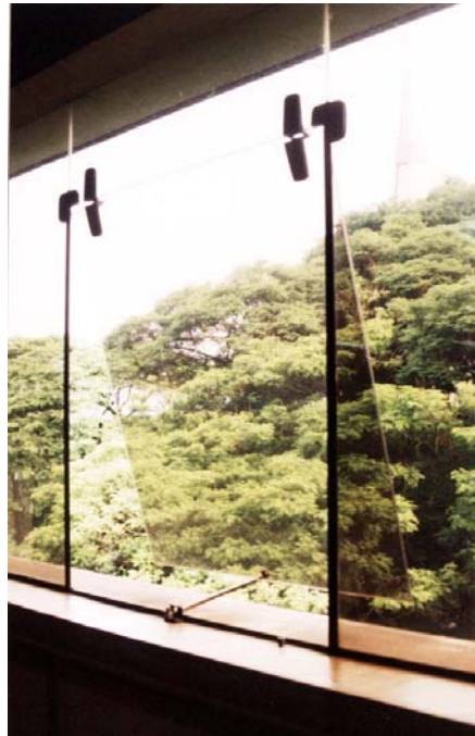
Figura 3.7: Detalhe da janela tipo maxi-ar.
