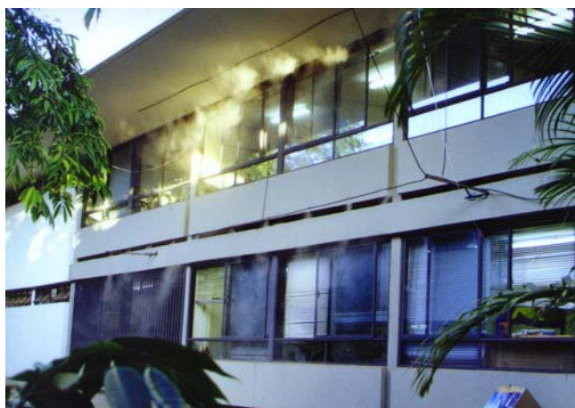
FIGURA3.29- Desenho esquemático da instalação do sistema de resfriamento evaporativo. FIGURA3.30- Vista sistema em funcionamento.
