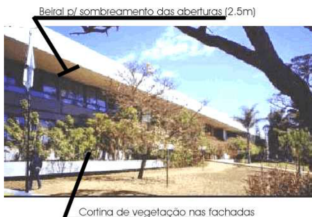
FIGURA 3.10- Vista da Fachada Principal do Edifício.
