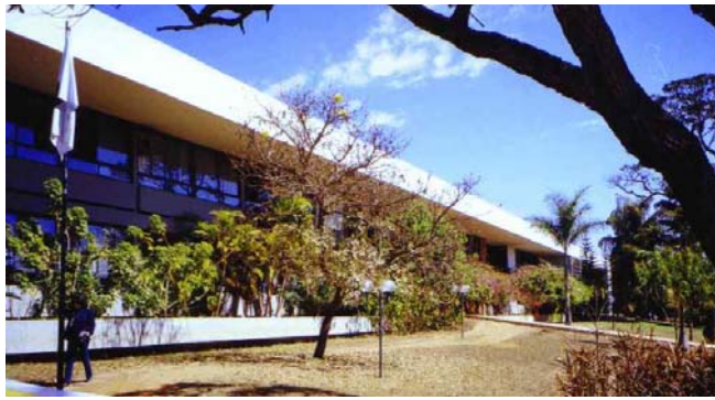
FIGURA 3.2- Fotografia fachada principal do edifício da Câmara legislativa do Distrito Federal.
