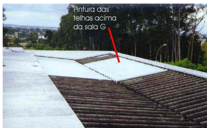
FIGURA3.33- Telha pintada de branco sobre a cobertura da sala G.
