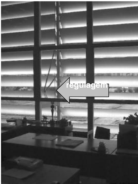
Figura 4.5 - Brise com acionamento interno, do edifício sede da Eletrosul.
