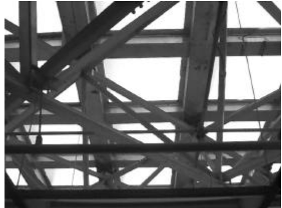
Figura 4.81 - Vista interna do domo.
