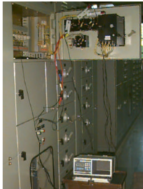
Figura 3.6 - Medição de cargas elétrica com o RE1000.
