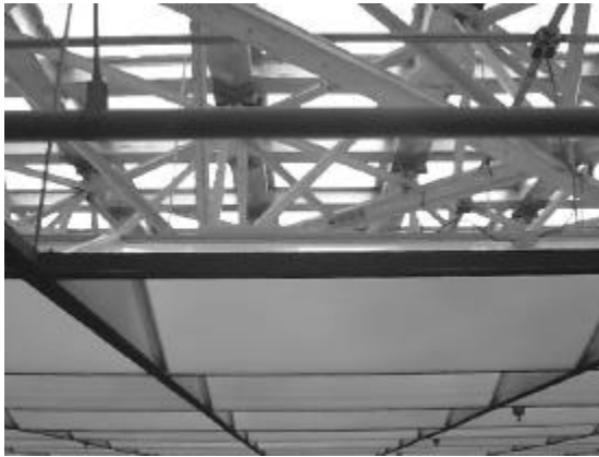
Figura 4.82 - Detalhe do vão livre entre a luminária e o domo.
