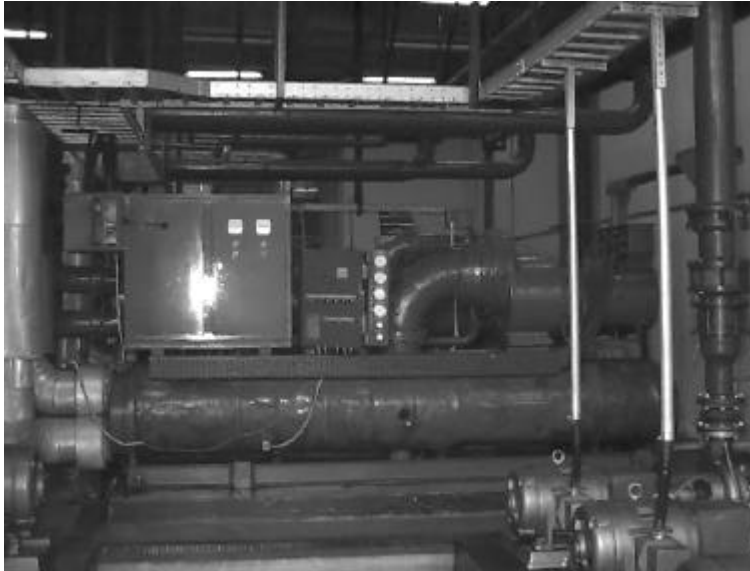
Figura 4.55 - Detalhe de uma das centrífugas de 400 TR.
