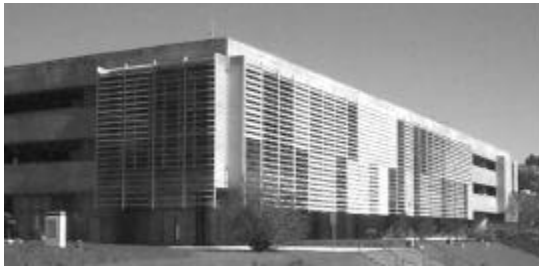
Figura 1.7 - Detalhe da fachada lateral.
