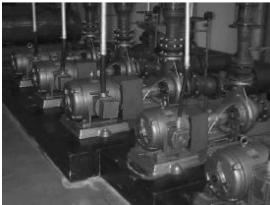
Figura 4.48 - Bombas de água de condensação.
