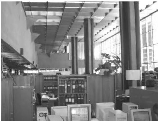
Figura 4.30 -Detalhe de área com pé-direito diferenciado.
