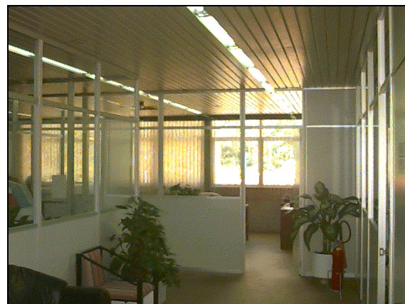
Figura 3 - Sistema de iluminação
